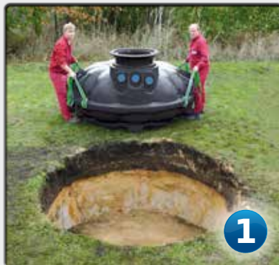
Einfacher und leichter Einbau eines 3000 Liter NEO Flachtanks: Grube ausheben, Flachtank einlassen, Grube füllen, Fertig!
