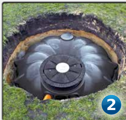
Einfacher und leichter Einbau eines 3000 Liter NEO Flachtanks: Grube ausheben, Flachtank einlassen, Grube füllen, Fertig!
